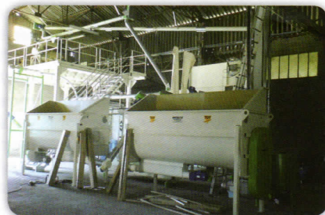
✱ L'installation de production Calys à Étampes.
